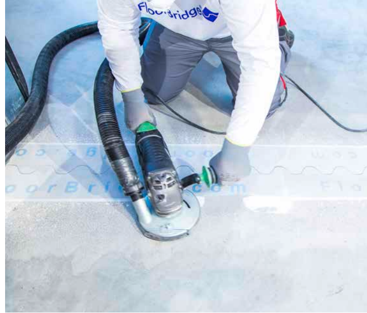
Einbau eines innovativen Fugenprofils in Carbonfaser-Verbundbauweise
