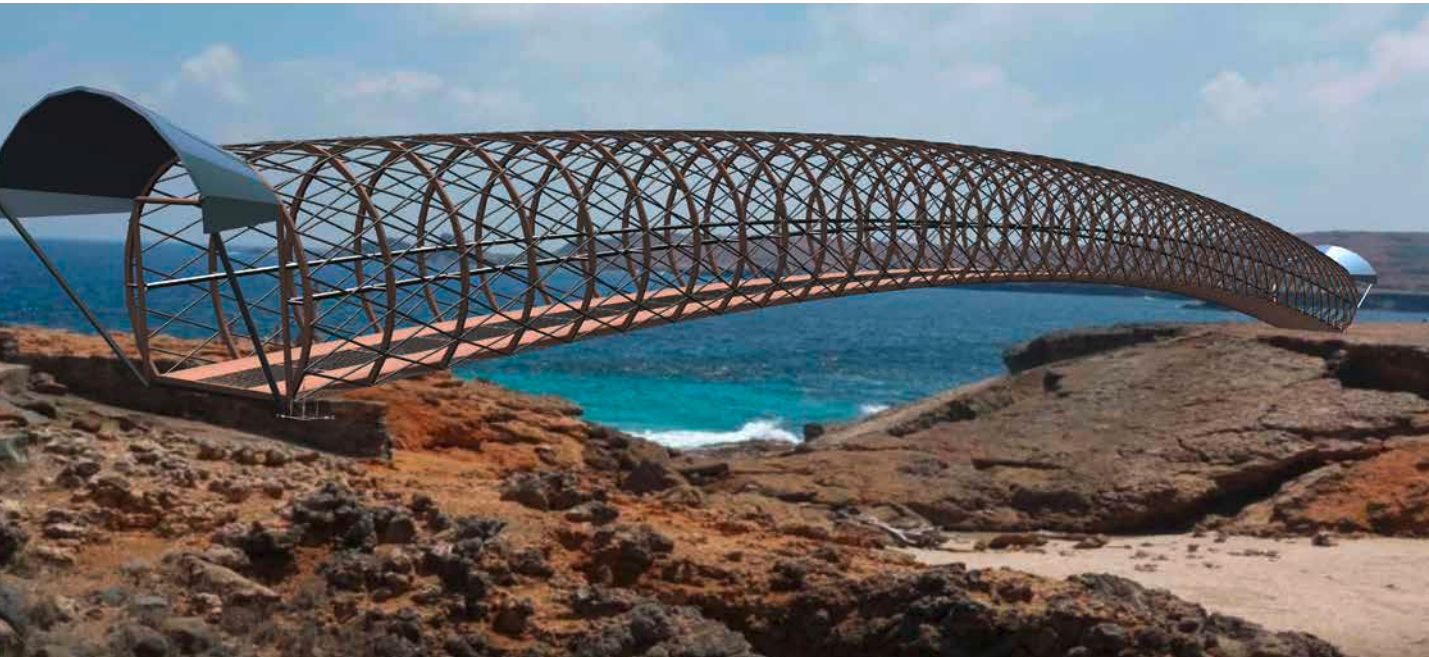
Entwurf einer faserverstärkten Kunststoff-Brücke
